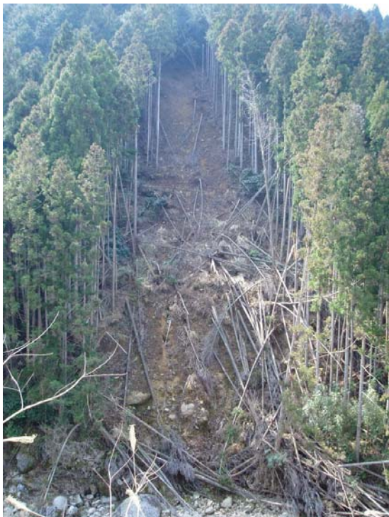
沢抜け（旧足助町地内）
