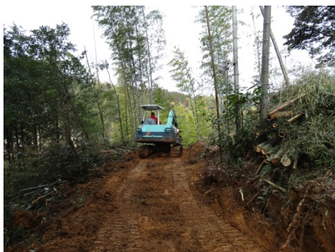
作業道を整備することで安全な作業ができるようになりました
