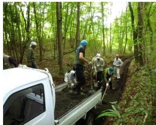
作業道の整備風景
